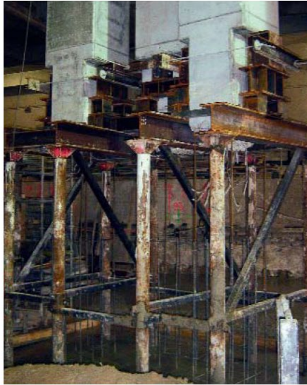
Photo n° 11 : reprise en sous-œuvre par micropieux
