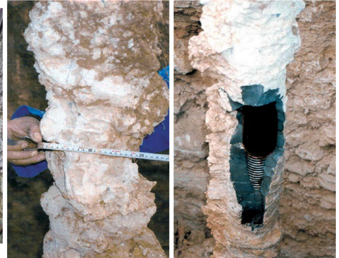
Photo n° 13 : bulbes de boulons d'ancrage déterrés (photos Ischebeck).
