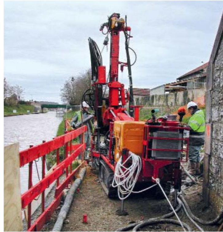
Photo n° 12 : sondeuse pour micropieux
